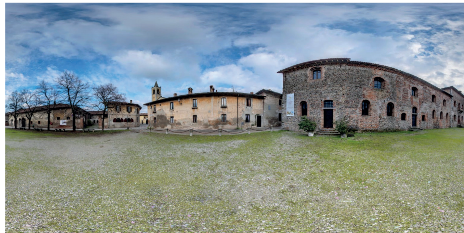
Il Castello Borromeo di Corneliano Bertario, foto di Danilo Bassani
